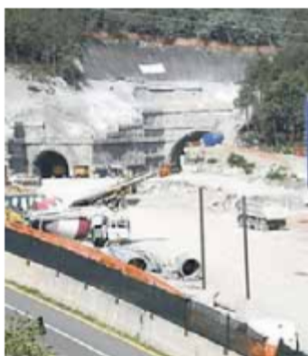
• Il cantiere della Loppio-Busa
