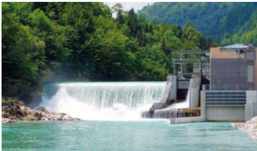
Centrale In Trentino sono in scadenza 17 grandi concessioni idroelettriche
