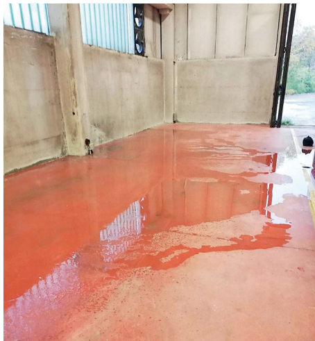
Pozzanghere dentro il deposito ex Bentivoglio di Cles
