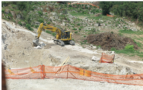
Cantiere Loppio-Busa, il 18 febbraio i sindacati incontreranno la giunta
