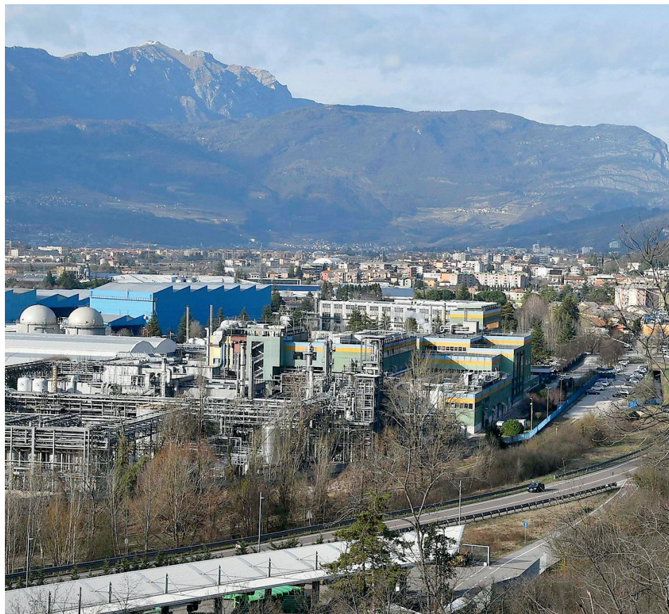
• L'impianto Sandoz in Zona industriale: qui lavorano da otto anni circa sessanta dipendenti della Pulicenter
