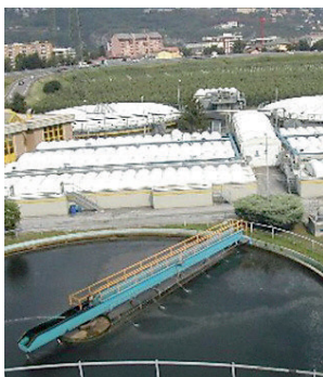
Un impianto di depurazione
