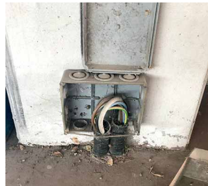
• Un quadro elettrico aperto al deposito ex Bentivoglio di Cles
