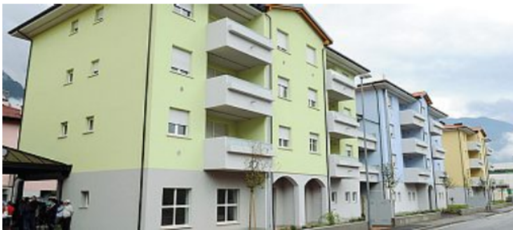
Priorità Alcune case Itea realizzate a Campotrentino nel Comune di Trento
