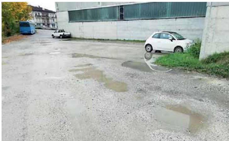
• Pozzanghere e fango nel piazzale davanti al deposito corriere di Cles
