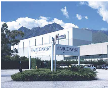
• La sede dell'Arconvert di Arco
