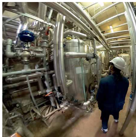
• Le verifiche quotidiane nella centrale termica del Santa Chiara
