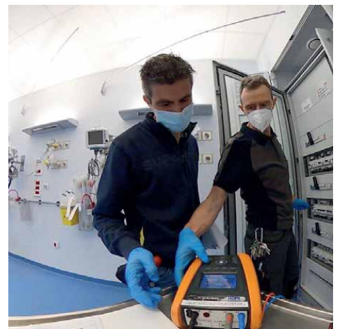
• Gli elettricisti controllano gli impianti del blocco operatorio
