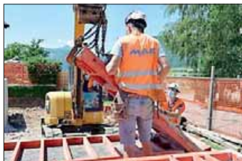
Operai della Mak al lavoro in cantiere
