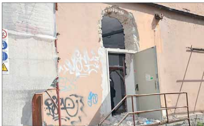
L'ingresso dell'ex magazzino oggetto di ristrutturazione da una settimana
