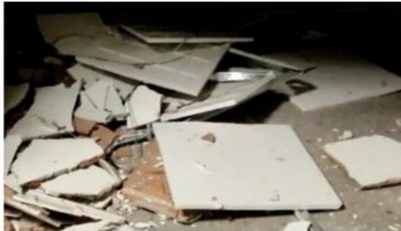
I danni Il solaio crollato all'Isti Buonarroti era esteso su 10-15 metri quadrati per uno spessore di circa tre centimetri
