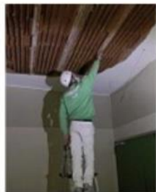
Il ripristino Operai già al lavoro ieri
