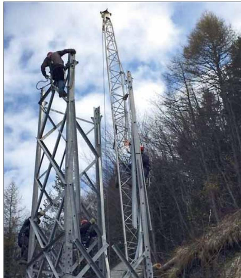
Operai addetti al montaggio di un traliccio per l'energia elettrica
