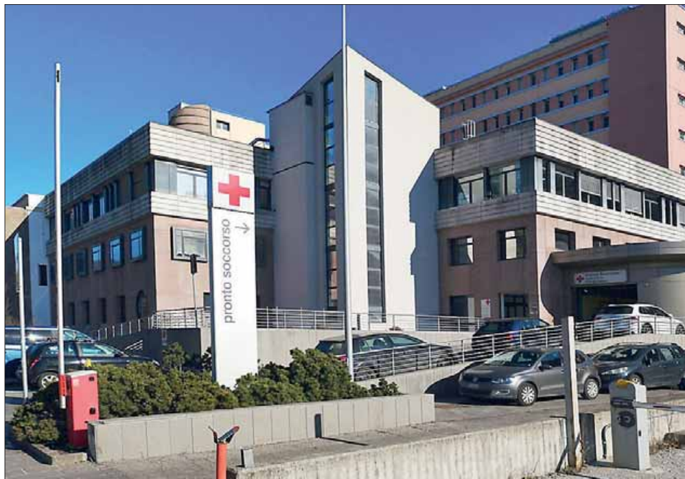
L'ospedale Santa Maria del Carmine di Rovereto ha alcuni problemi strutturali
