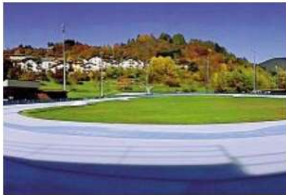
Anello L'ice Rink Piné, struttura pre-olimpica di Milano-Cortina
