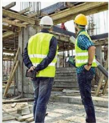
Al lavoro Tecnici in un cantiere edile
