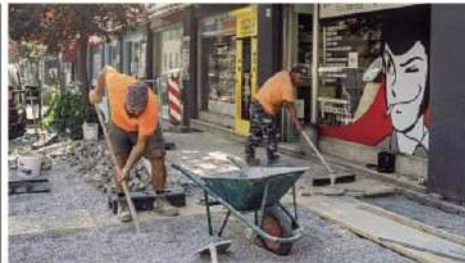
Via Perini Due lavoratori ieri pomeriggio in un cantiere stradale in città a Trento (Foto: Ecol/LaPresse)
