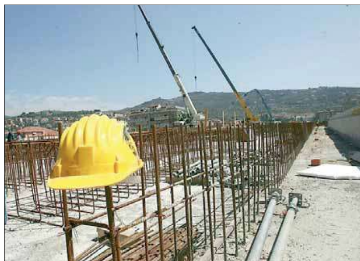
In molti cantieri trentini è una corsa contro il tempo
