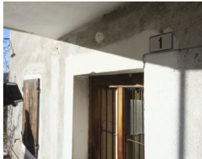
Salvataggio La porta da cui sono entrati i soccorritori © Nardelli
