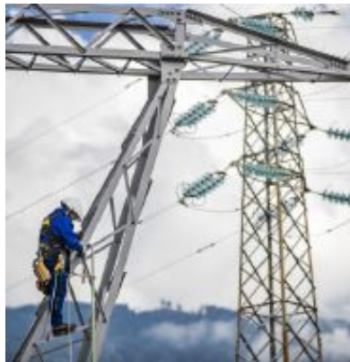
Elettricità un operaio a lavoro
