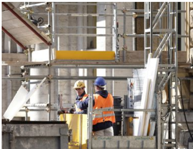
Cantieri Operai a lavoro su progetti Pnrr
