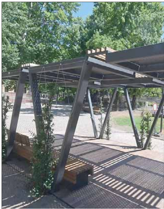
L'area anti caldo in costruzione in Largo Pigarelli
