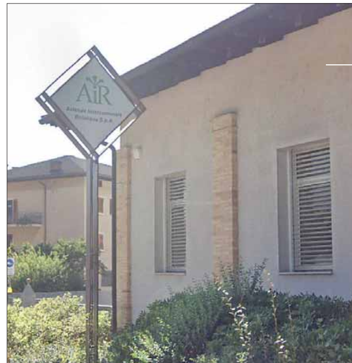
La sede di Air, Azienda intercomunale della Rotaliana. I Comuni soci stanno valutando la vendita della rete elettrica
