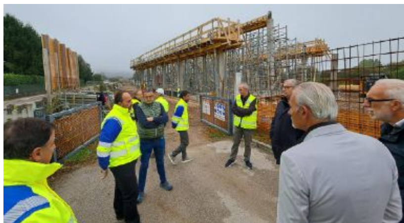
Il sopralluogo Fugatti, sindaci e tecnici in visita al cantiere della ferrovia
