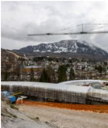
Cortina Un cantiere per le Olimpiadi
